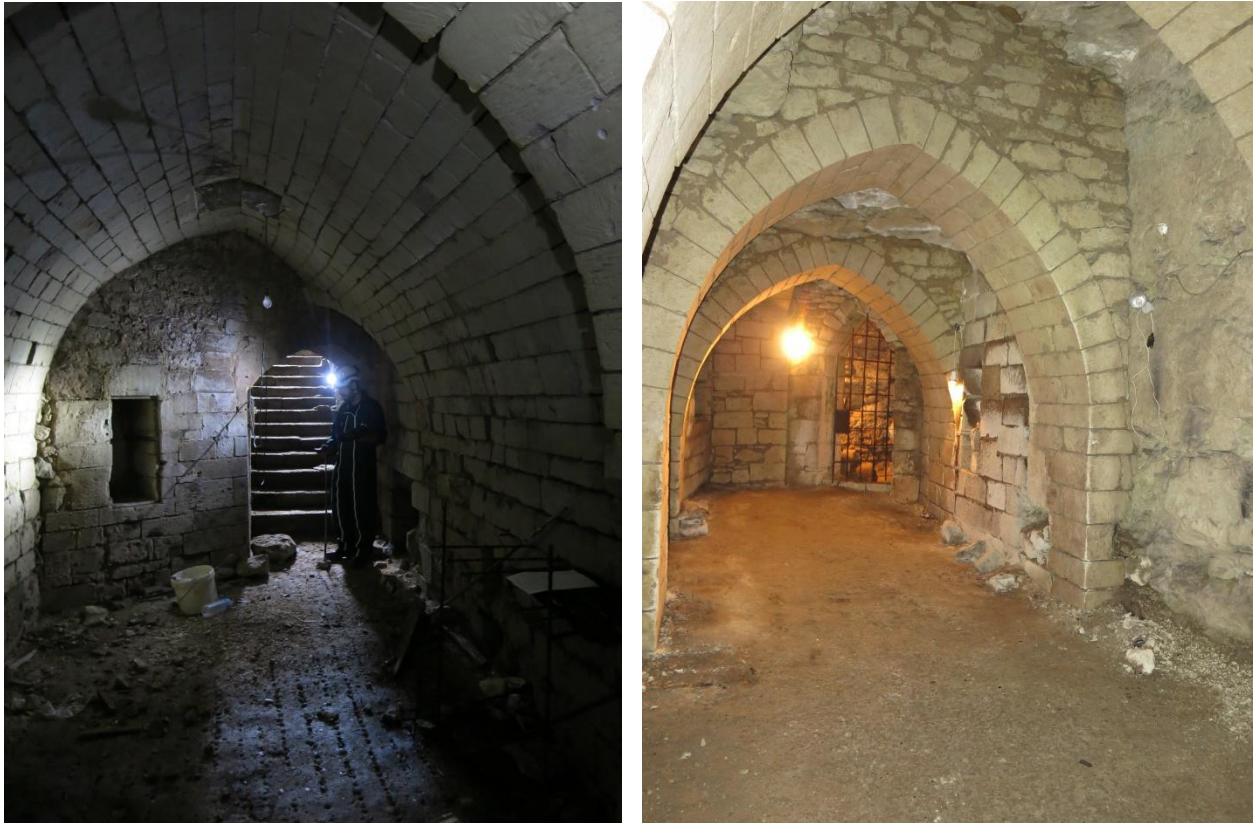
Illustration 6 – Photo de cavités parées de pierres de taille (n° 146 à gauche et n° 2057 à droite)
