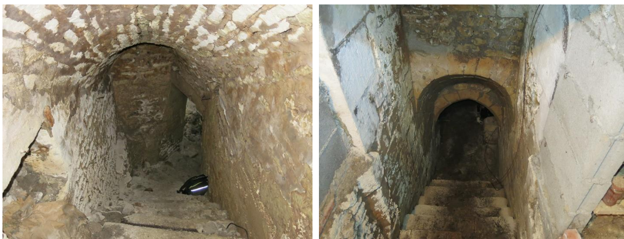
Illustration 8 – Photos d'accès par escalier (à gauche cavité n° 2054, à droite cavité n° 2017)
